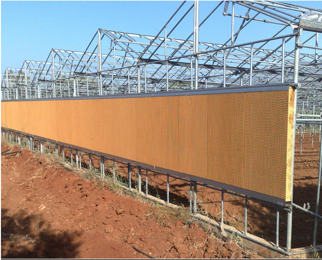
Τοποθέτηση πάνελ κατά την κατασκευή του θερμοκηπίου
